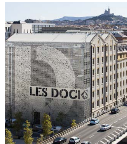
Marseilles Docks, Marseille/France (2009-2015)
