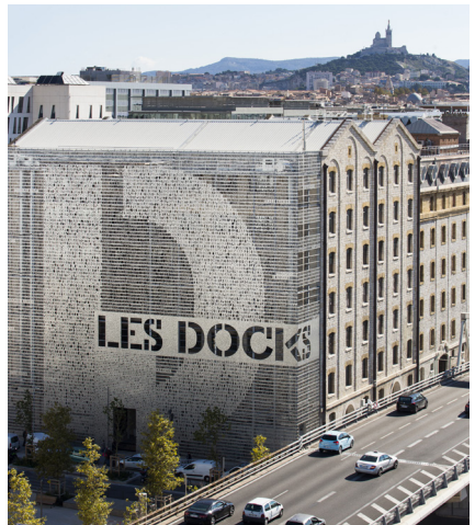
Marseilles Docks, Marseille/France (2009-2015)
